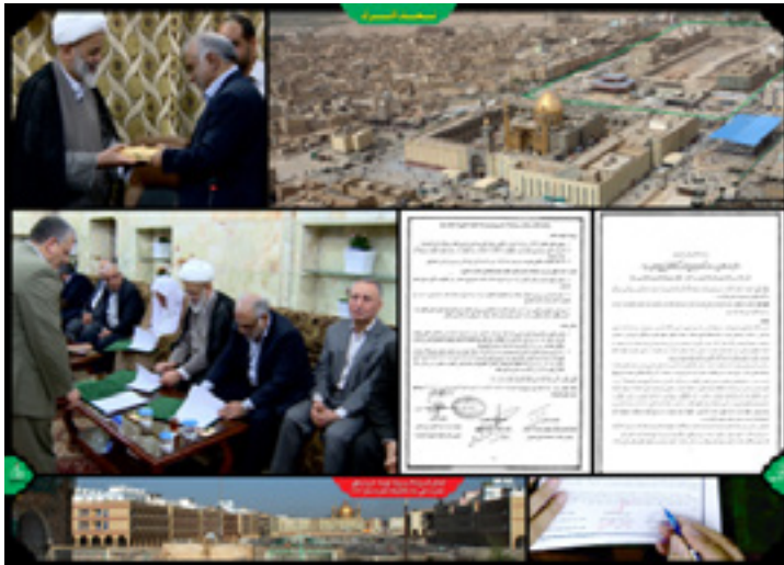
مراحل ساخت طرح توسعه حرم مطهر امام علی علیه السلام صحن و شبستان حضرت زهراء علیها السلام نجف اشرف
