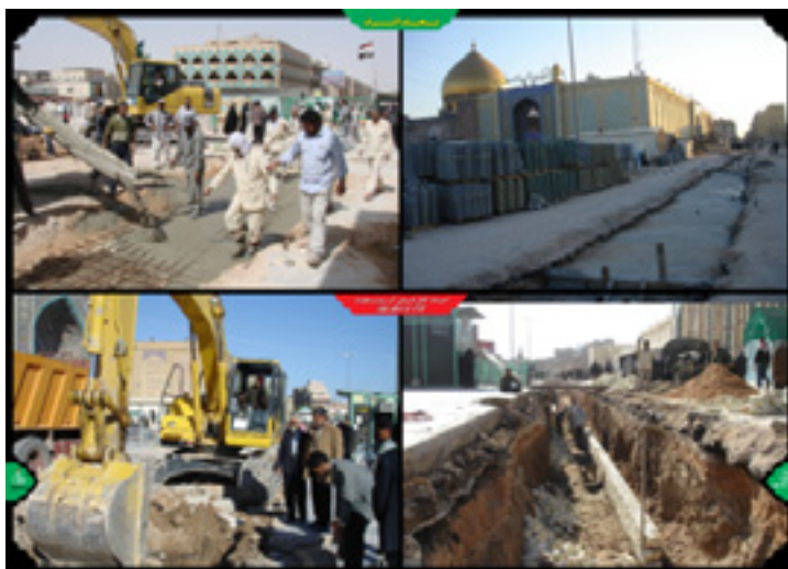
احداث تأسیسات کانال های انتقال آب به حرم مطهر امام علی علیه السلام نجف اشرف
